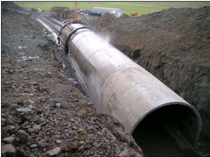
Mynd 4.2.3. Bygging vegskála í Fáskrúðsfirði (Ljósmynd: Sigurður Oddsson, ágúst 2004).
