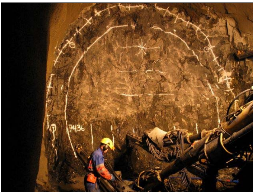
Mynd 4.1.1. Hleðsla og borun í Fáskrúðsfjarðargöngum (Ljósmynd: Sigurður Oddsson, maí 2004).
