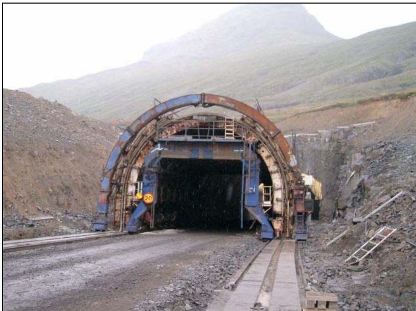
Mynd 4.2.4. Bygging vegskála í Fáskrúðsfjarðargöngum (Ljósmynd: Sigurður Oddsson, ágúst 2004).
