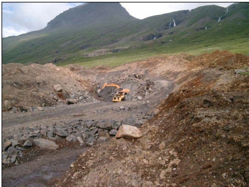
Mynd 4.2.2. Unnið í forskeringum í Fáskrúðfirði (Ljósmynd.: Sigurður Oddsson, júní 2003).
